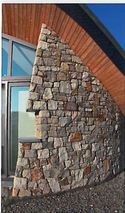
©Pierres et Marbres de Wallonie
